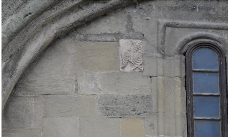
სურ. 17. სვეტიცხოველი, მრავალფრთედი ჩრდილოეთ ფასადზე
